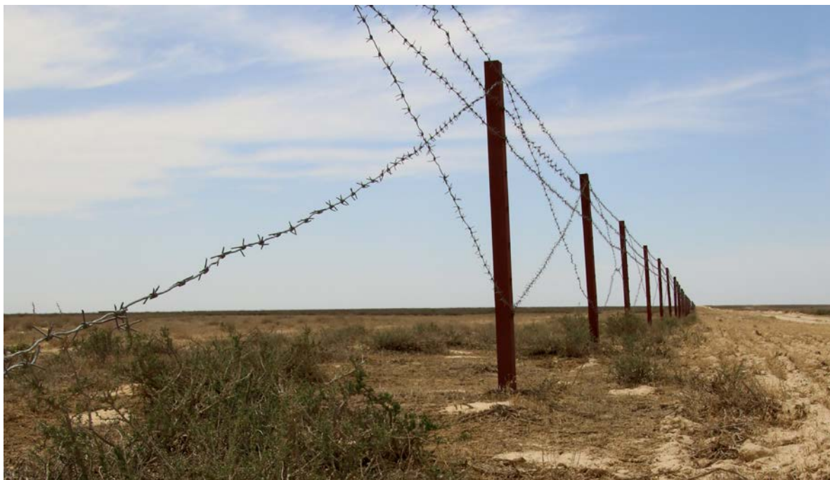
Рис. 20. Проход для мигрирующих сайгаков протяжённостью около 11 км на участке государственной границы Казахстана с Узбекистаном в пределах Актюбинской области РК: демонтированы пять нижних рядов колючей проволоки. Фото М. Пестова.
