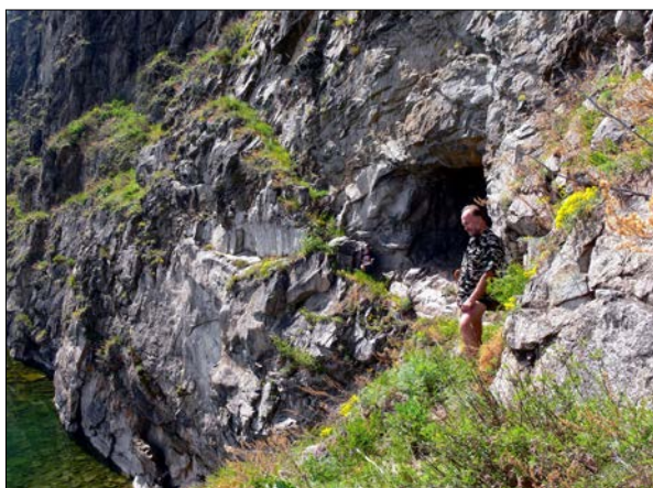
Рис. 7. Вентиляционные выходы Кругобайкальской ж.д.
