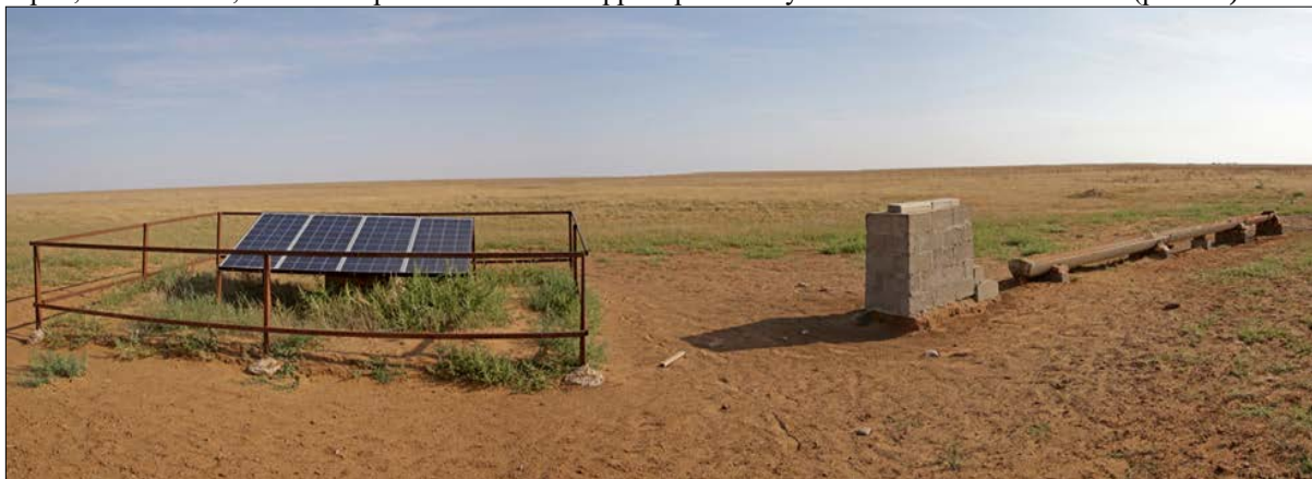
Рис. 21. Автономная поилка для животных, периодически накачивающая воду из специально оборудованных скважин в соответствии с запрограммированным таймером за счёт энергии, получаемой от солнечных батарей. Заповедник Чёрные Земли, Республика Калмыкия, Россия. Фото М. Пестова.
